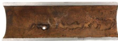
Şəkil 2. 180 sutka istismardan sonra Ø73x5,5 mm borunun metalının korroziya dağılması
