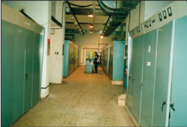
ŞƏKİL 6. “SURA” STANSİYASININ İDARƏETMƏ MƏRKƏZİ
