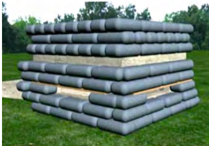
Şəkil 4. Dəmir-beton lövhələrdən yığılmış bunker
