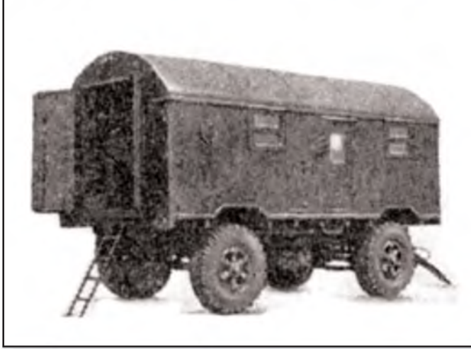
ŞƏKİL 8. EPAS STANSİYASININ ESDA-100-T/400-1RK ELEKTRİK ENERJİ VERƏN
